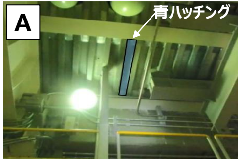
デッキプレート（天井を見上げた図）
