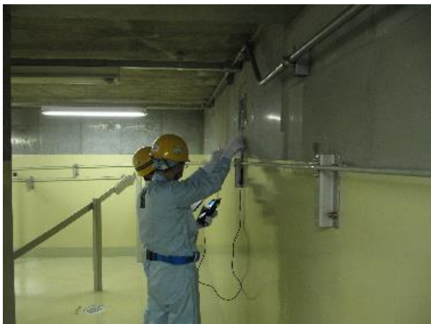
風量測定実施状況
