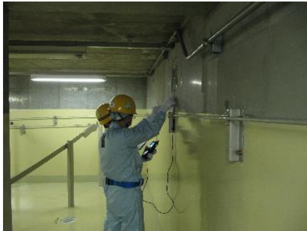
風量測定実施状況
