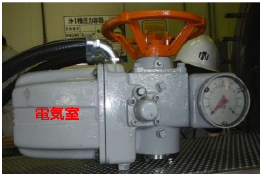
電動弁駆動部
