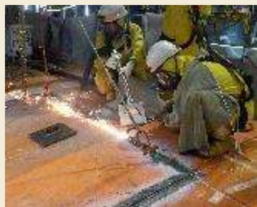
①解体・運搬ルート確保
