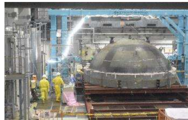
大型バンドソーによる切断作業
