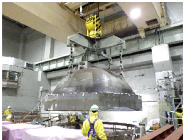
圧力容器上蓋 取り外し
